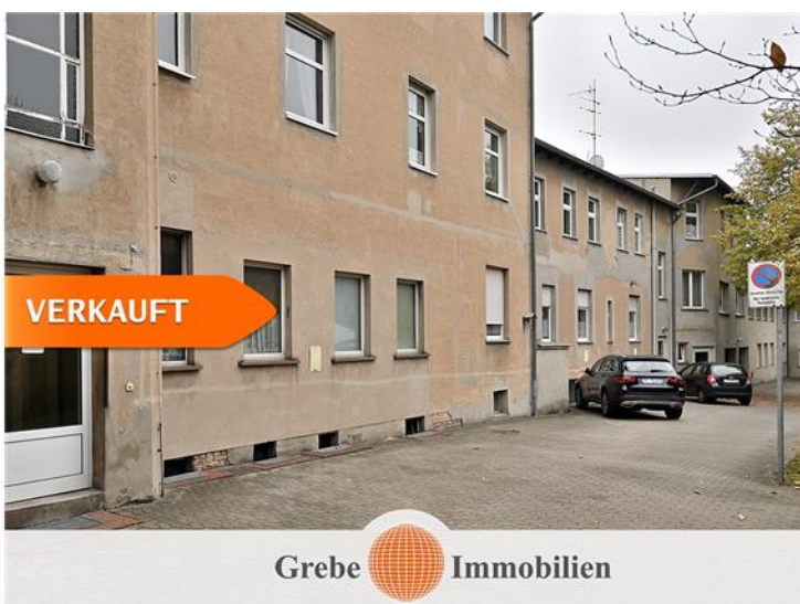
Zugang EG und OG
