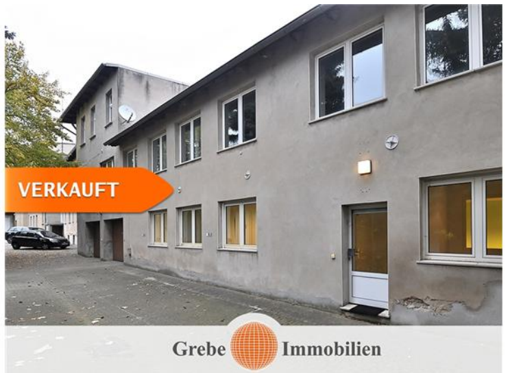
Zugang freies Gewerbe
